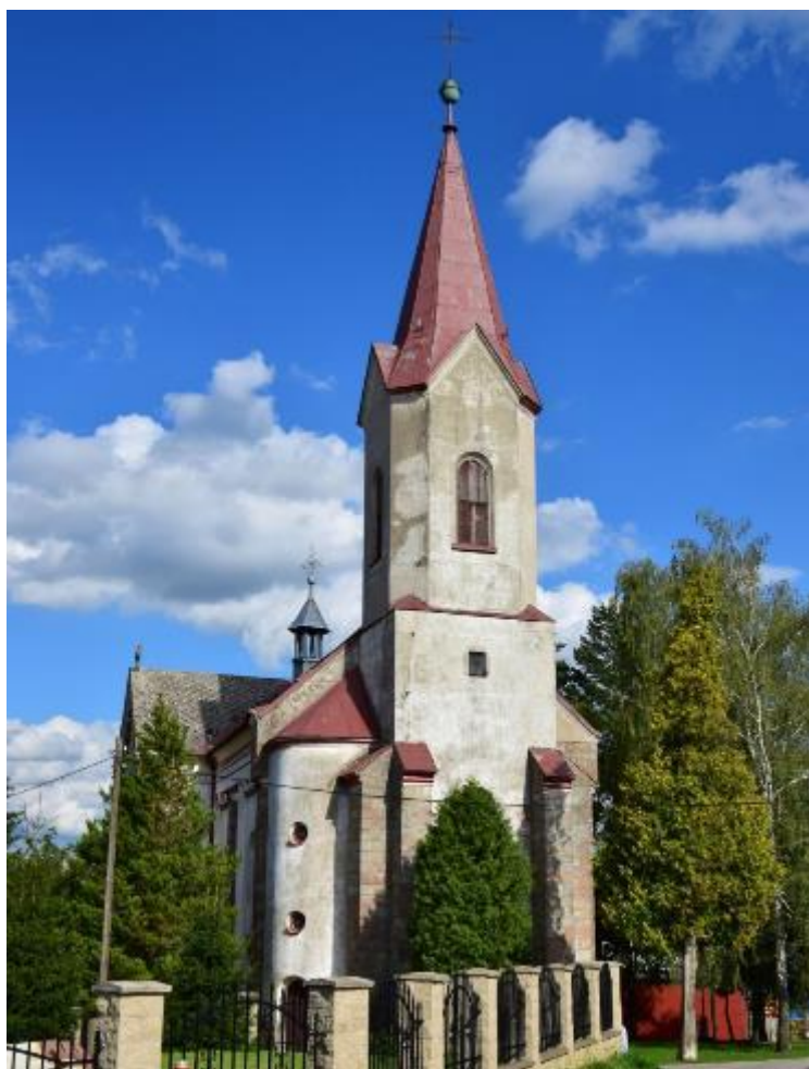
Obrázek 11: Kostel sv. Jiří, Dolní Branná
